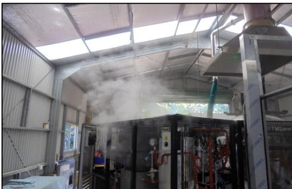
ඡායාරූපය - කෑගල්ල රෝහලේ Meta Mizer යන්ත්‍රයෙන් පිටතට හුමාලය පිටවන බව
