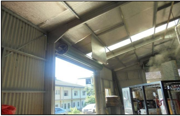
ඡායාරූපය - රත්නපුර රෝහලේ Meta Mizer යන්ත්‍රයෙන් පිටතට හුමාලය පිටවන බව
