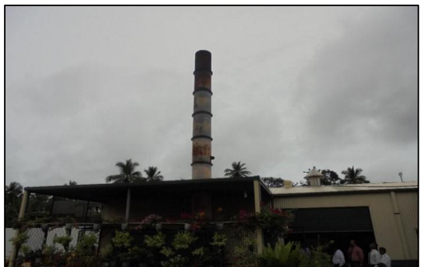
ඡායාරූපය - පොළොන්නරුව රෝහලේ Incinerator යන්ත්‍රයේ විමිතිය පහළ මට්ටමක පැවතීම
