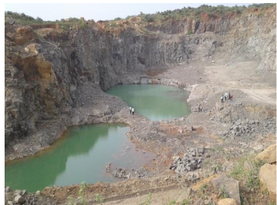
රූපසටහන 26 - දක්ෂිණ අධිවෙහි මාර්ගයේ කි.මී.CH8+250-500 ස්ථානයේ යෝජිත මාර්ගය මධ්‍යයේ අනවසර ලෙස කැණීම් කර තිබුණු ගල්වල (මිනින්දෝරු දෙපාර්තමේන්තුවේ මැනුම් අනුව ගැඹුර මීටර් 28 කි)
