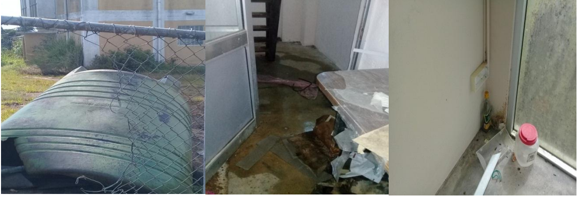
எந்தவொரு நபரும் இலகுவாக நுழையக்கூடிய வகையில் வேலைத்தள பாதுகாப்பு வேலி வெட்டப்பட்டிருத்தல்
