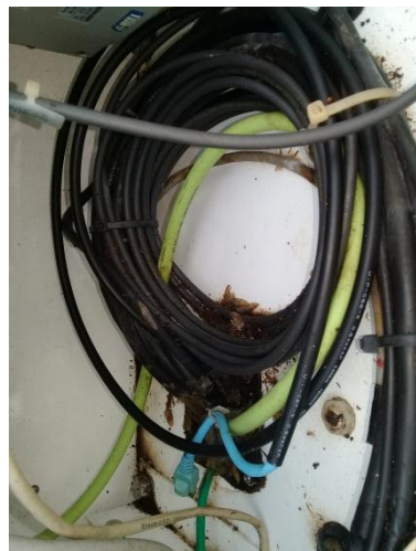
වාගොල්ලේ කාලගුණ විද්‍යා මධ්‍යස්ථානයේ පිහිටි AWS පද්ධතියේ Data logger හි කෘමි කොටස් රැදී ඇති ආකාරය (2019.03.06)
