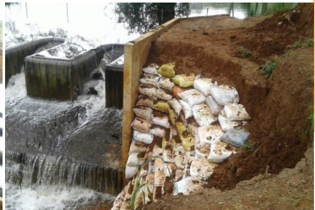
පිටවනට වඩා කුඩා පාලම භාග්‍යාරක්ෂිත ඉවුර පිටාර ජලය හේතුවෙන් ඉවුර සේදීගොස් ඇති ආකාරය
