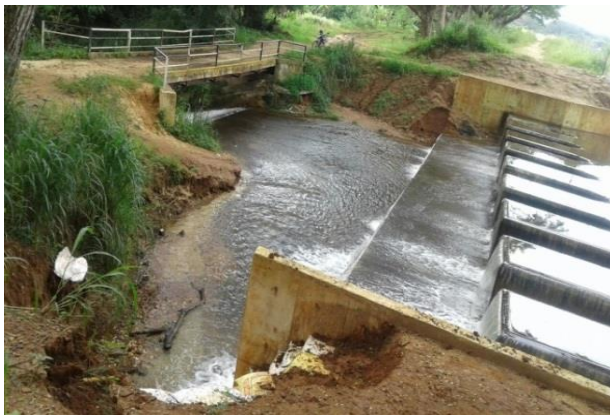
පිටවනට වඩා කුඩා පාලම භාග්‍යාරක්ෂිත ඉවුර පිටාර ජලය හේතුවෙන් ඉවුර සේදීගොස් ඇති ආකාරය
